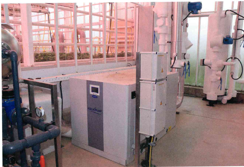
De koude van de warmtepomp wordt gebruikt om vocht uit de kaslucht te halen, de warmte om de lucht op te warmen. Wordt er meer koude geproduceerd dan nodig, dan wordt die in een gemodelleerde – want niet reëel aanwezig – ondergrondse opslag bewaard, en gebruikt voor koeling in de zomer.
